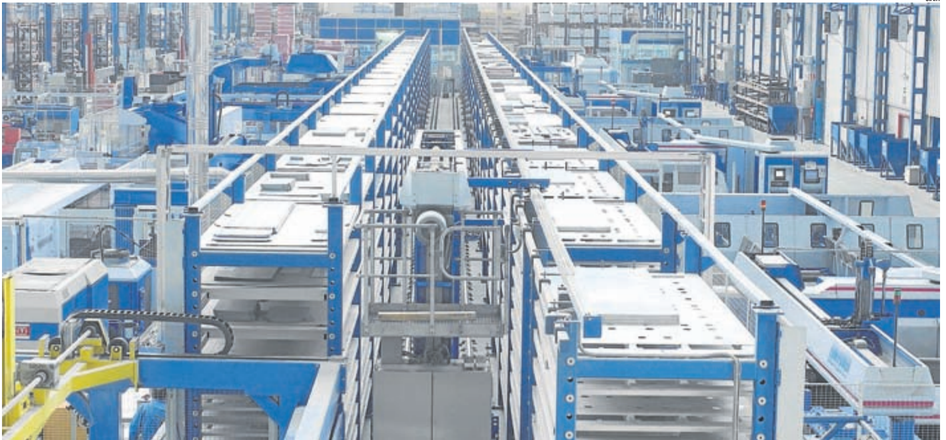
Instalaciones. Detalle de la fábrica de Infrico en Lucena.
